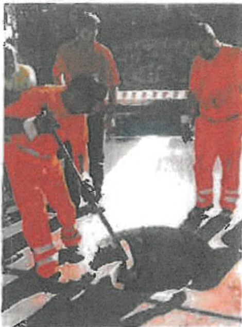
A szilárd betongyűrű rögzítése után megtisztítjuk a felületet.
