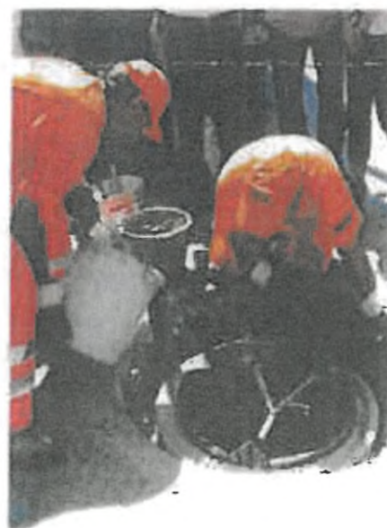
Speciális gyorsító habarccsal történik a beépítés – kötés idő csak pár perc!
