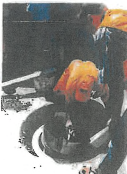
A szintező betongyűrű rögzítése speciális gyorsító habarccsal történik.
