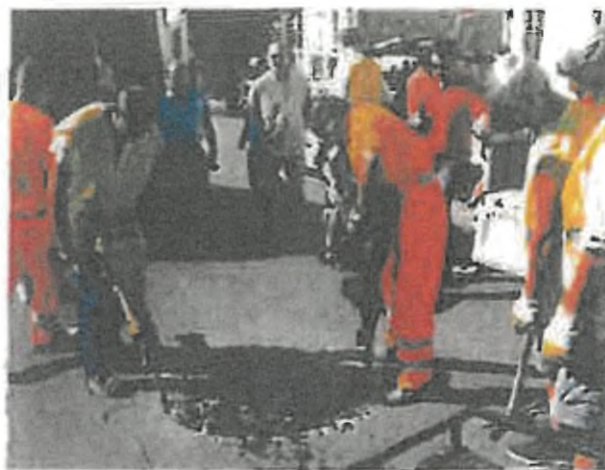
Az elhasználódott fedlap kibontása. Látható, hogy nincs szükség több négyzetméteres földet megbontásra, csak a fedlap közvetlen 15-20 cm környezetét kell megbontani.
