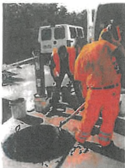
Aszfalt bedolgozás a munkagödörbe.
