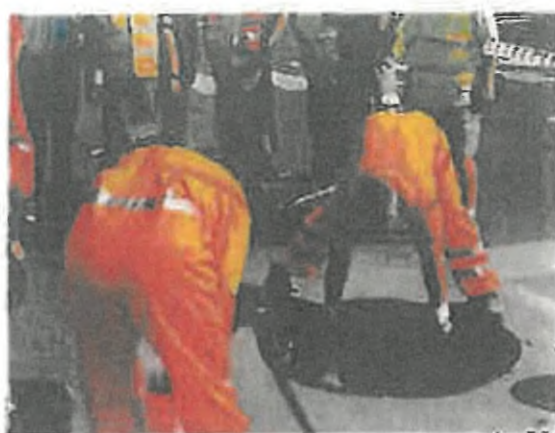
Bent maradó adaptergyűrű elhelyezése
