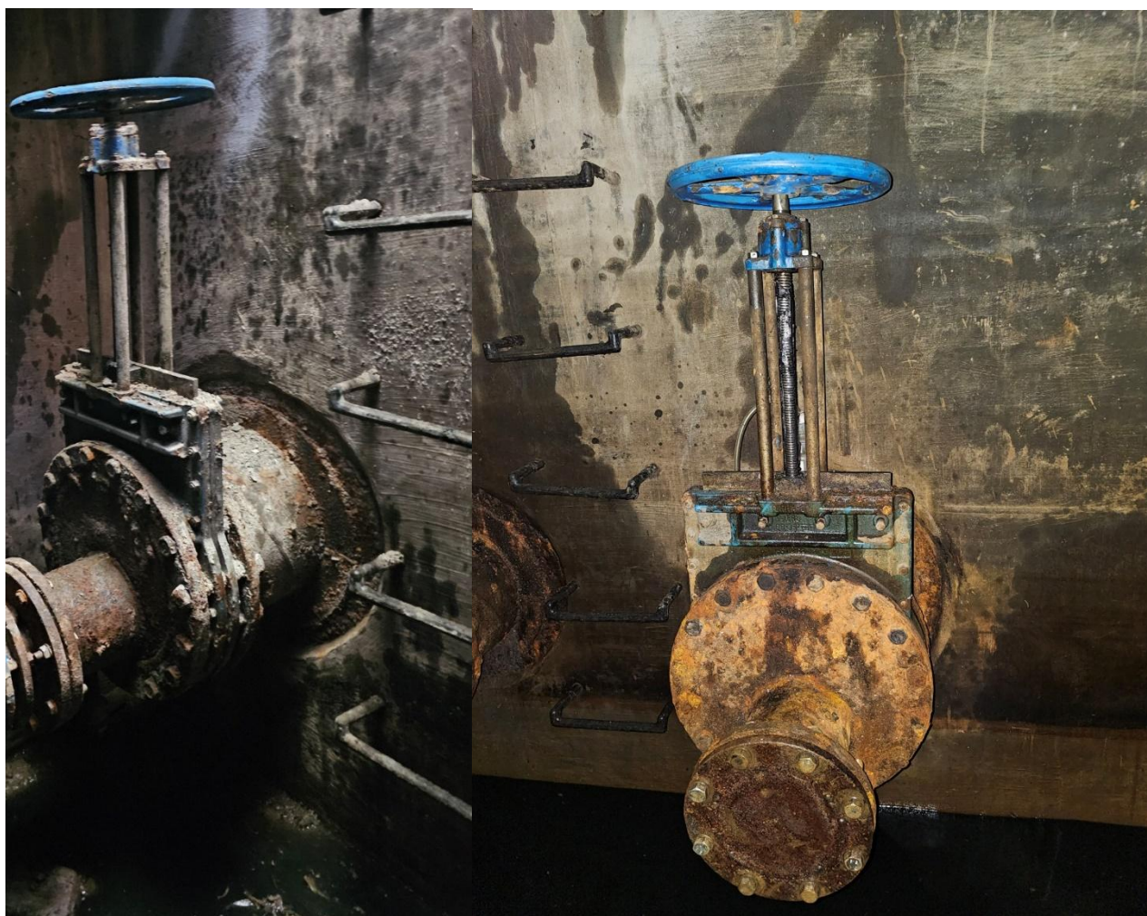
5. ábra Meder utcai ürítő szerelvény
