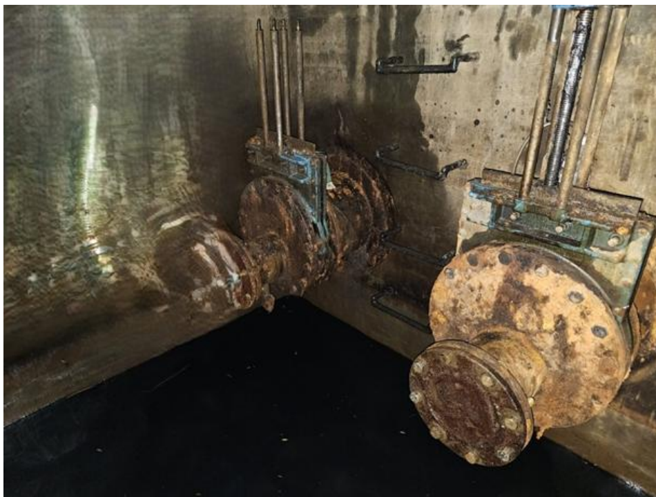
4. ábra Meder utcai ürítő szerelvények
